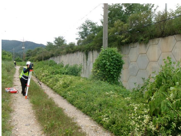
광파기를 이용한 측량 작업
