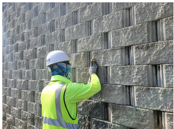
경사계를 이용한 경사도 측정
