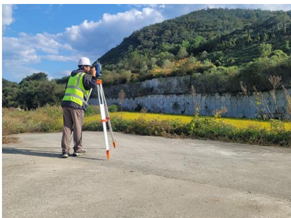
광파기를 이용한 측량 작업
