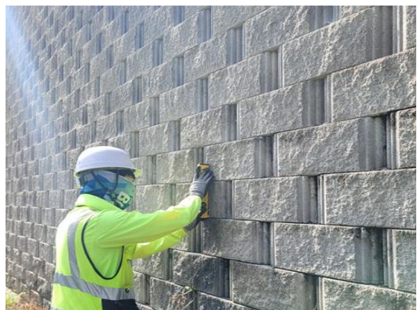
경사계를 이용한 경사도 측정
