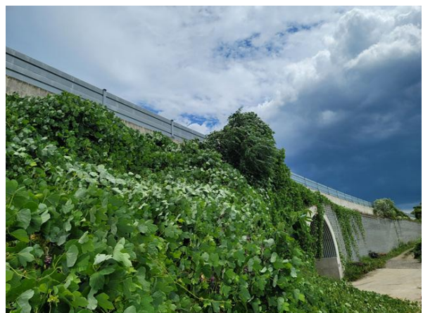
상부 성토부 전경
