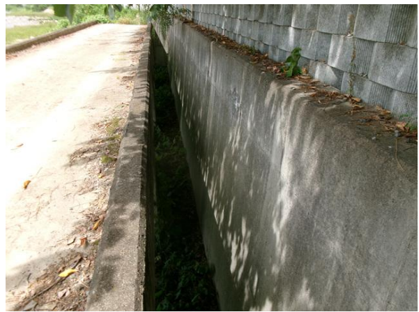
하부 배수로 전경
