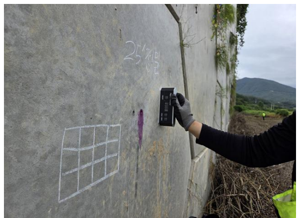
경사계를 이용한 경사도 측정
