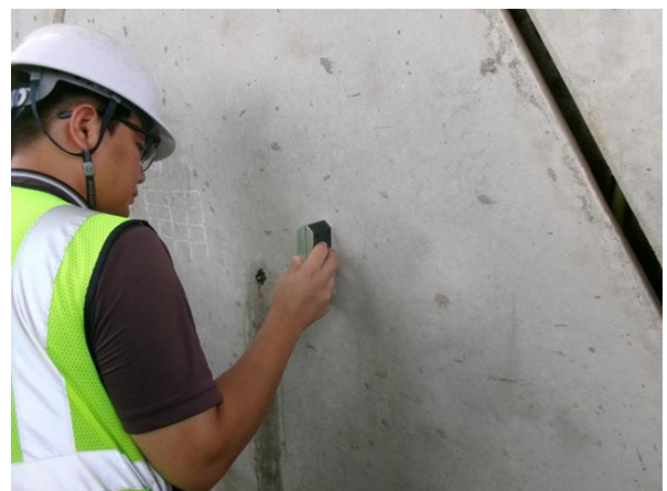
경사계를 이용한 경사도 측정
