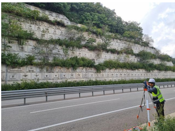
광파기를 이용한 측량 작업
