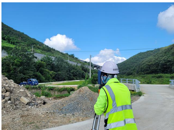
광파기를 이용한 측량 작업
