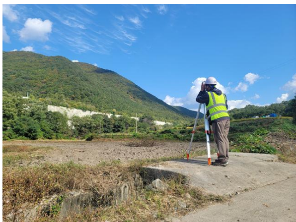
광파기를 이용한 측량 작업
