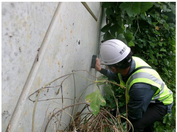
경사계를 이용한 경사도 측정
