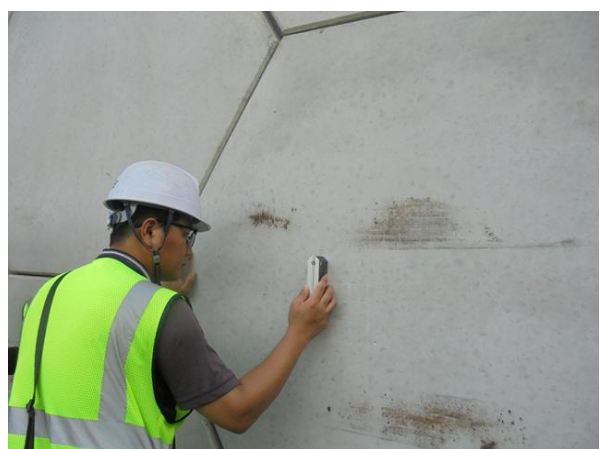
경사계를 이용한 경사도 측정
