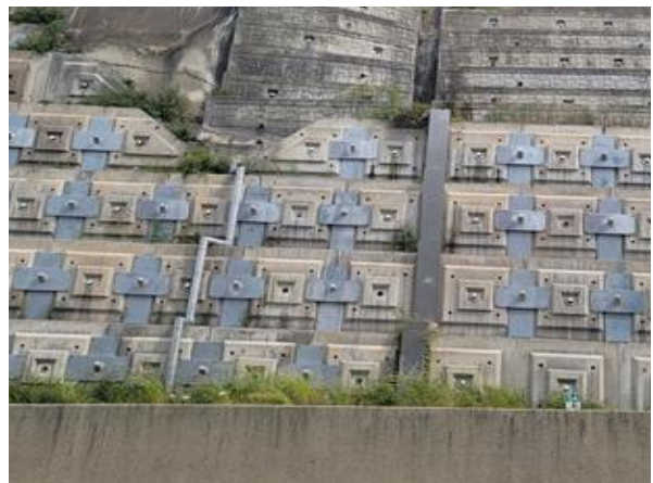
배수관, 배수로 전경
