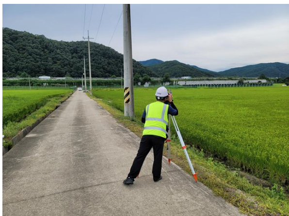
광파기를 이용한 측량 작업
