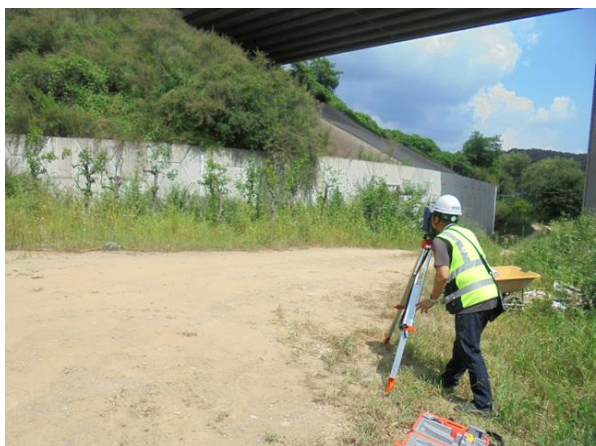
광파기를 이용한 측량 작업
