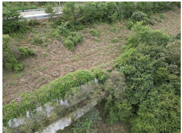
상부 성토부 전경
