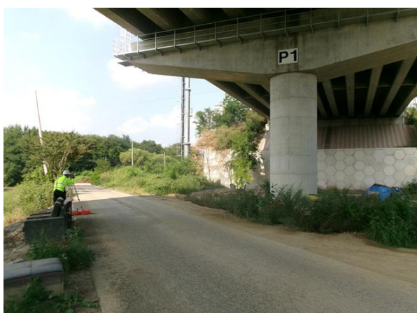
광파기를 이용한 측량 작업
