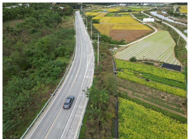
상부 성토부 전경
