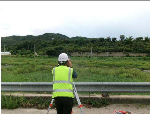
광파기를 이용한 측량 작업
