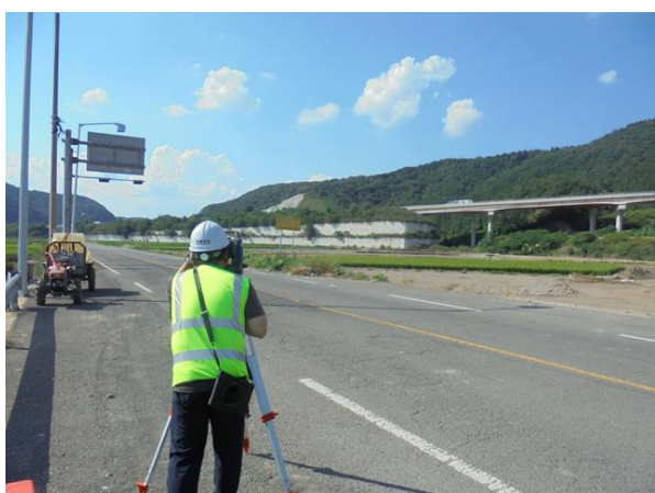
광파기를 이용한 측량 작업
